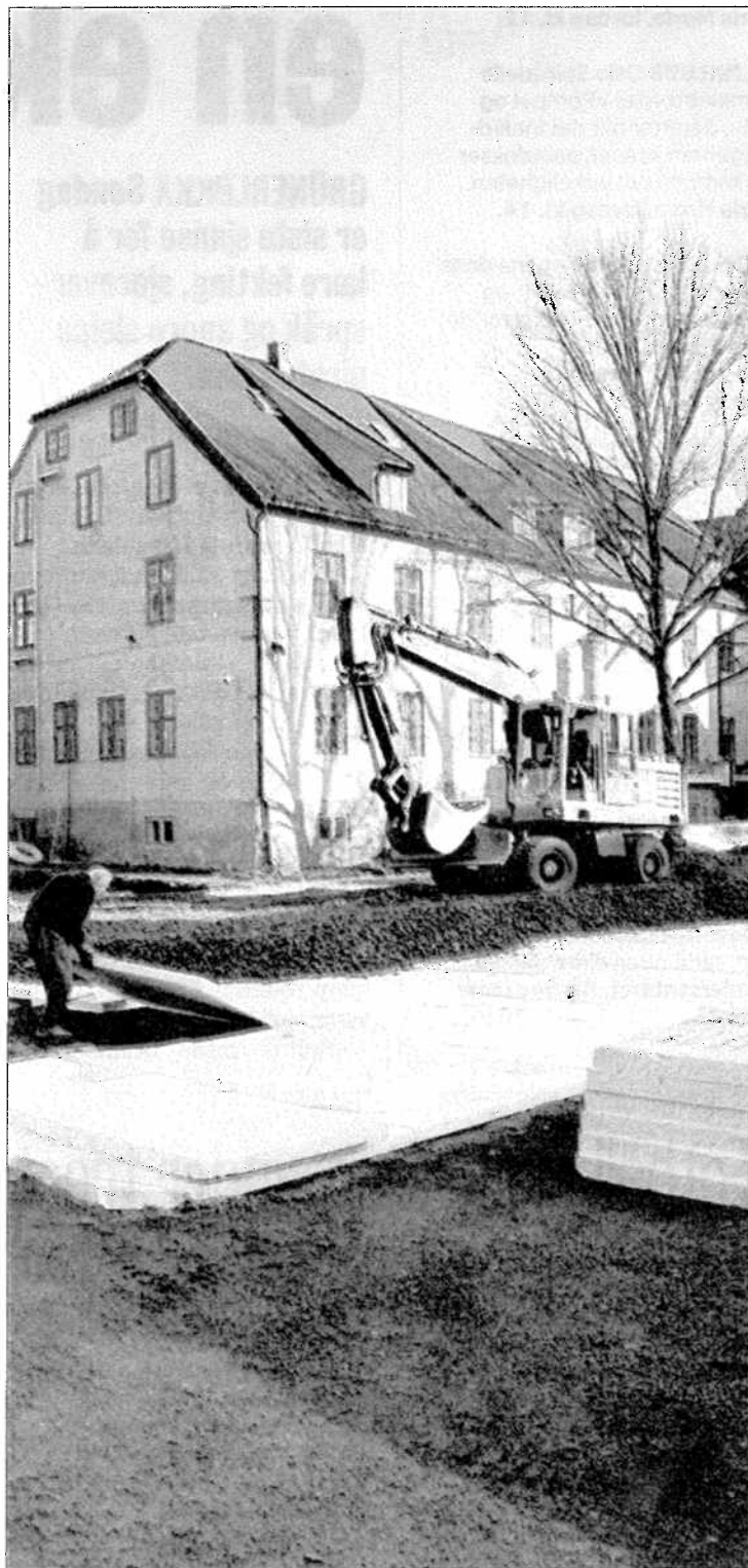
Her, i bakgården til Storgata 36, kommer sprøyterommet. Arbeidet med å forberede grunnen er allerede i gang.
