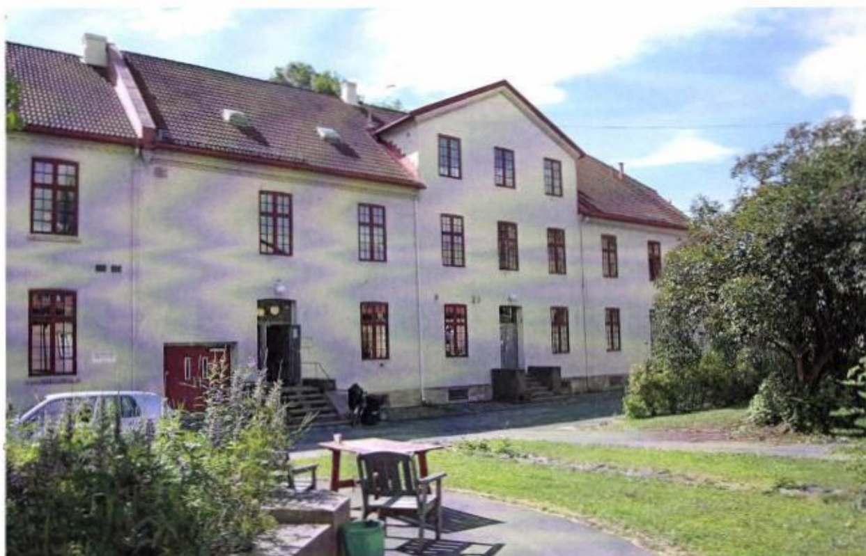
Fattigsykehusets fasade mot nordvest/gårdsrommet. Foto: Byantikvaren 2006
