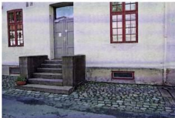
Eldre steinsetning mot Fattigsykehuset.
