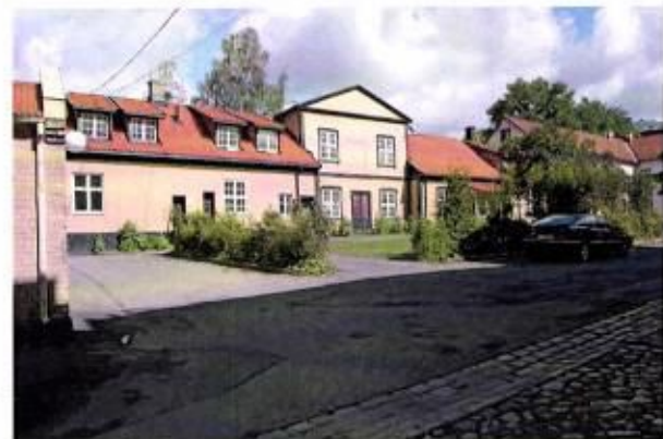
Bakfasaden. Foto: Byantikvaren 2006
