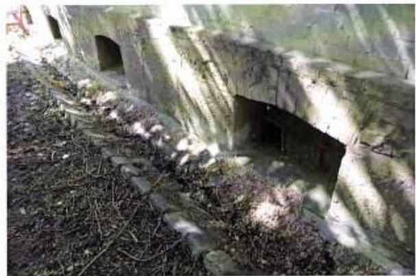
Steinsatt vannrenne ved Mannsavdelingen/asylgangen.
