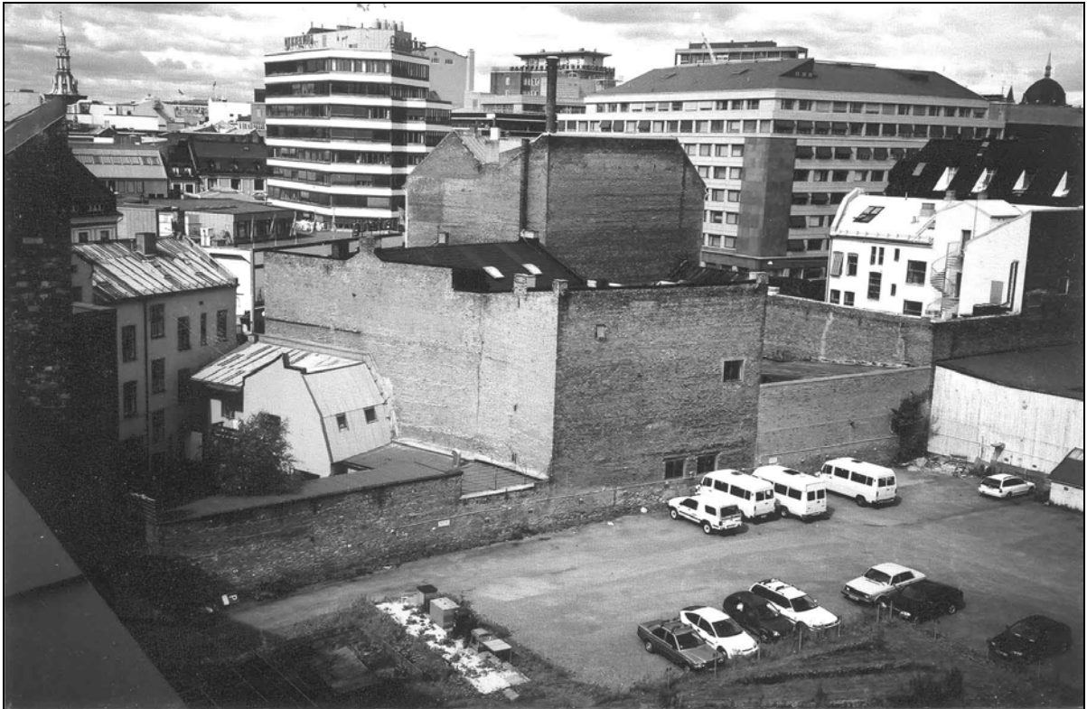
BRANNGAVLEN SETT FRA TAKET AV PARKERINGSHUSET
